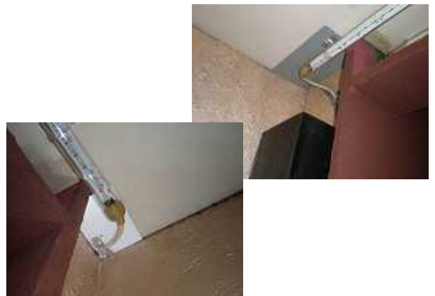
間接照明の裏側に配線スペースがあり、ネズミが出入りしていました。トタン板にて閉塞。
