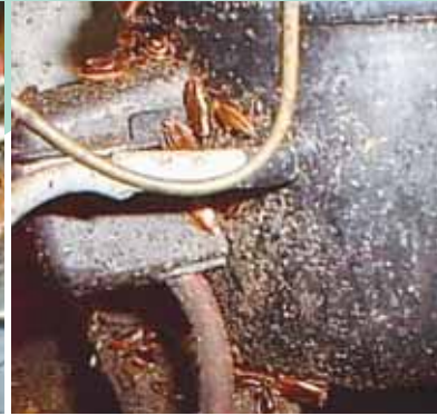
業務用冷蔵庫のモーター周り
